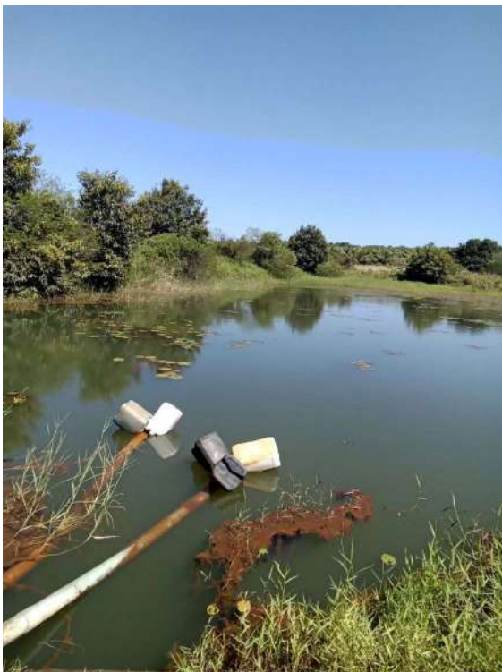
(e) Captação superficial em açude.
